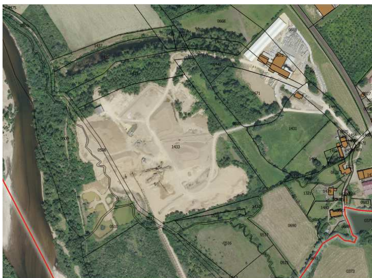
Carte 18 : Vue aérienne du site d'exploitation de matériaux de Saint Eloi (sables et graviers en provenance de la sablière sise sur la Commune riveraine de Chevenon)- Source BD ORTHO2 ©IGN 2020.
