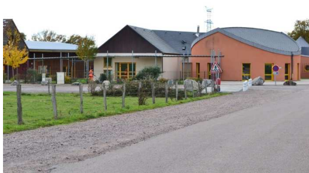
Figure 38 : École de SAINT-ELOI – Réalisation DORGAT
