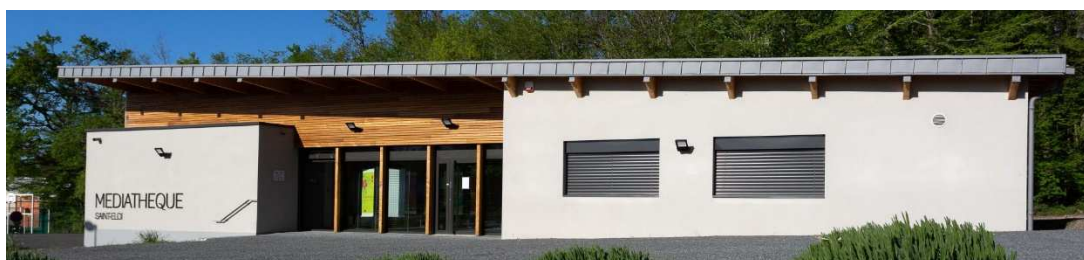
Figure 40 : Médiathèque de Saint-Eloi. Atelier d'architecture BENTEJAC® à Saint Martin d'Heuille
