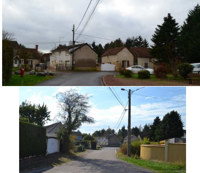
Figure 24 : Constructions anciennes Rue de Remeron – Source : DORGAT
