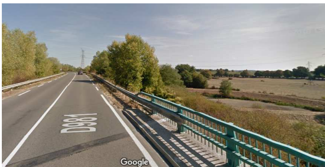
Figure 19 : Vue dégagée vers le sud-ouest depuis la RD 981, peu après la sortie de l'A77. Source : Google
