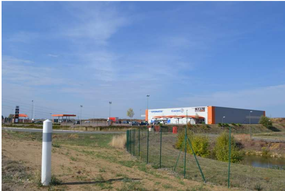
Figure 40 : Vue de la zone commerciale du Bouchot et de la Sablière – Source: DORGAT
