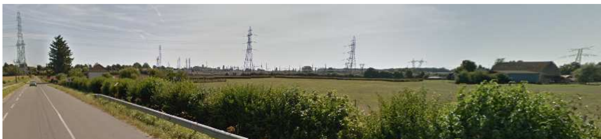
Figure 5 : Vue depuis le pont de la rue d'Aubeterre sur l'A77 vers le hameau et le centre technique d'Aubeterre
